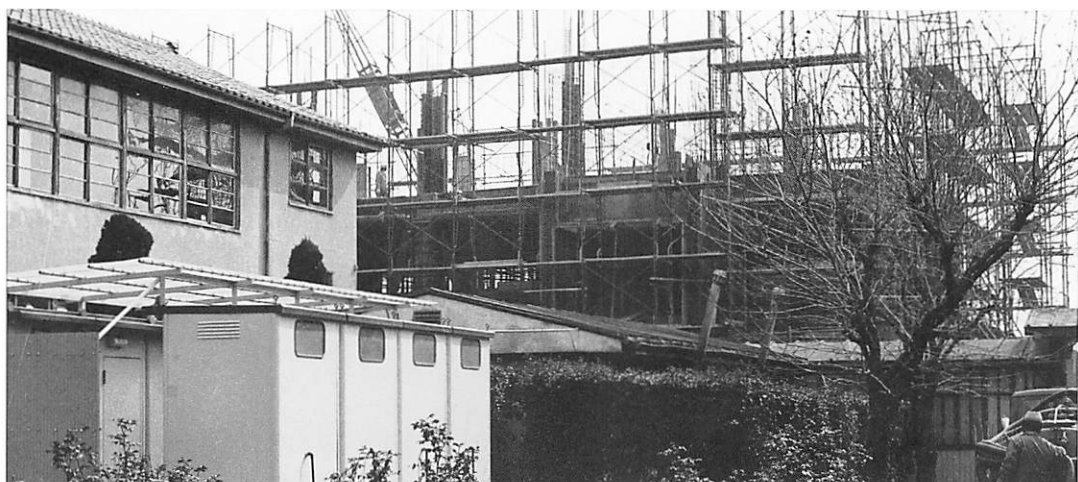
完成間近い南北棟と木造校舎(昭和53年)
