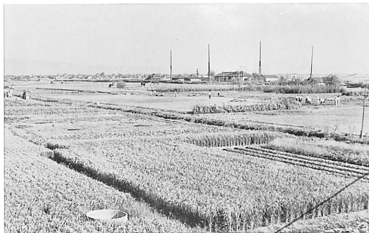
「建設前の敷地 整地がはじまる」
